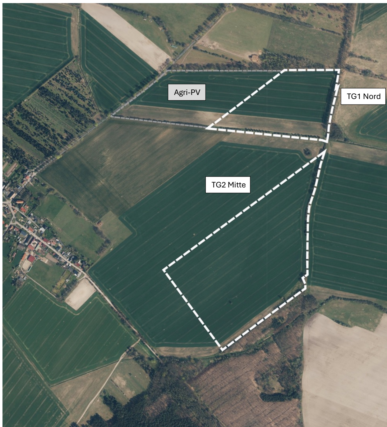
Abbildung 2: Luftbild mit teilträumlichen Geltungsbereichen TG1 (Nord) und TG2 (Mitte) des Bebauungsplans „Solarpark Danewitz“ (weiß gestrichelt) und westlich angrenzendem Geltungsbereich des in Aufstellung befindlichen Bebauungsplans „Agri-Photovoltaikanlage Danewitz“ (grau gestrichelt); © GeoBasis-DE/LGB, dl-de/by-2-0, (Daten geändert)
